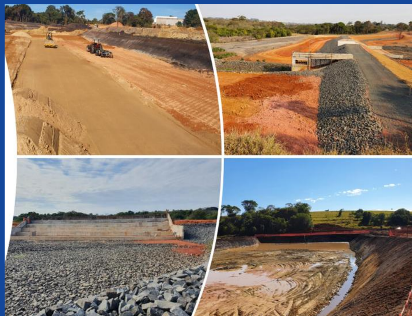
Barragem Córrego da Lagoa Novembro de 2021.
