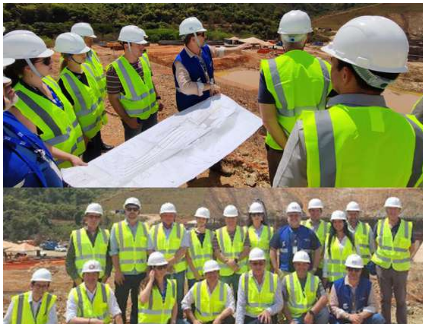
Visita Técnica às obras da Barragem de Pedreira, rio Jaguari – dia 30/09
