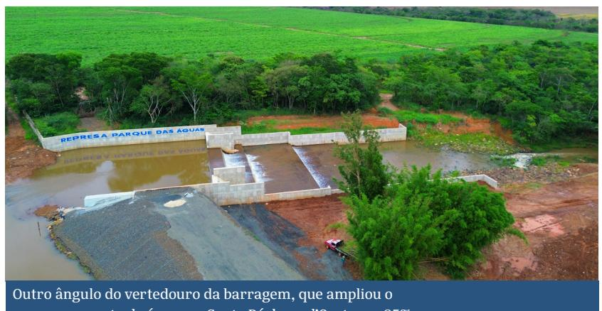
Outro ângulo do vertedouro da barragem, que ampliou o armazenamento de água em Santa Bárbara d'Oeste em 25%.
