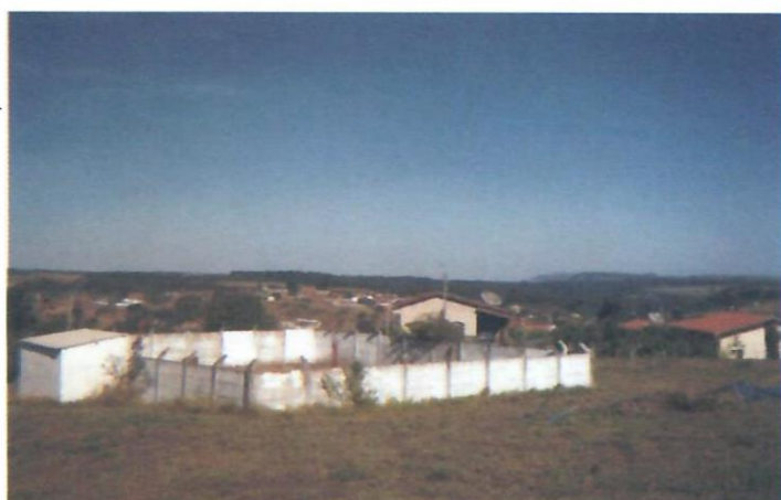
Reservatório capacidade para 300 m 3 , abastecido por gravidade pela captação tipo "Dreno"
