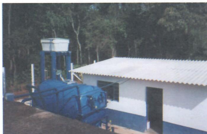
Estação de Tratamento, sistema isolado Loteamento Alpes Dòuro / 20 m 3 /h
