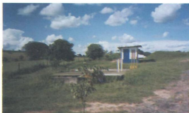
Reservatório capacidade para 100 m 3 Localizado na saída da ETA
