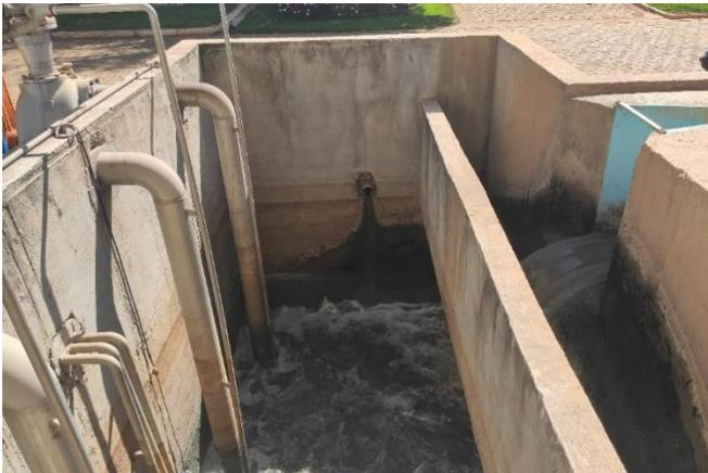
conhecer as instalações e os problemas enfrentados no tratamento do esgoto urbano. A referida ETE é responsável pelo tratamento de mais de 60% do esgoto coletado no município, e tem apresentado baixa eficiência em razão do carreamento do lodo durante o lançamento do efluente final.
