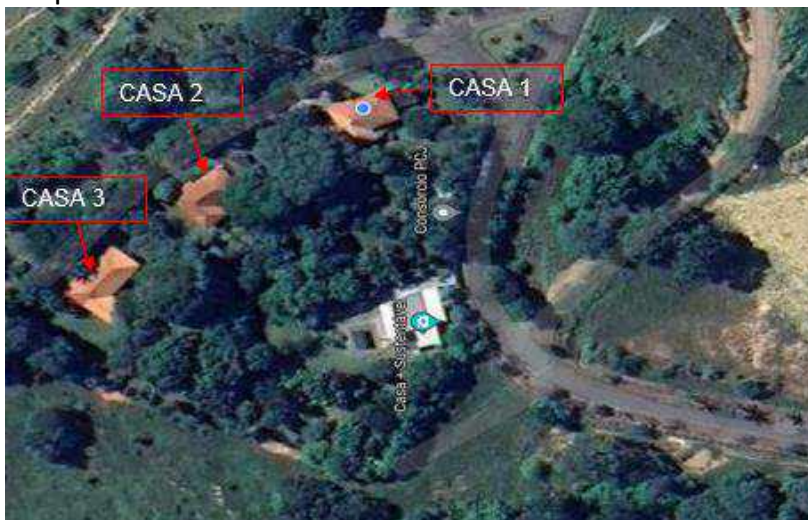
VISTA AÉREA DO LOCAL DA OBRA
