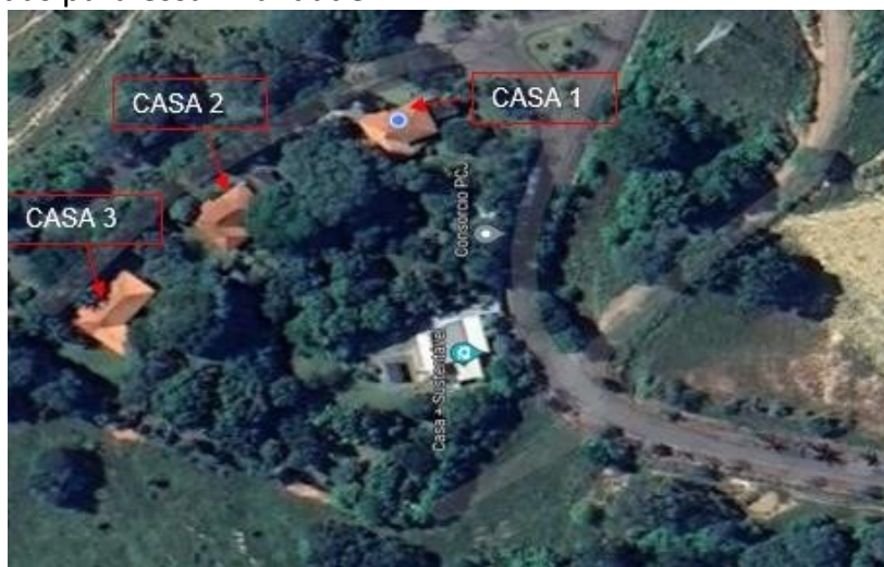
VISTA AÉREA DO LOCAL DA OBRA
