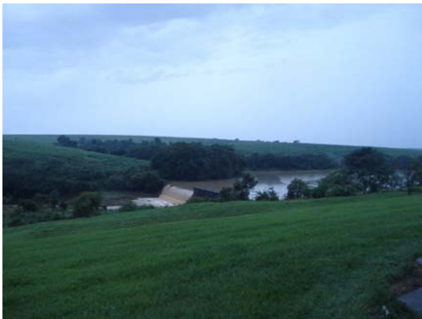
Imagem da represa Milhã em evento de cheia, após rebaixamento de 1,5 metro de altura da coluna d'água. Fonte: Pacheco, 2009.
