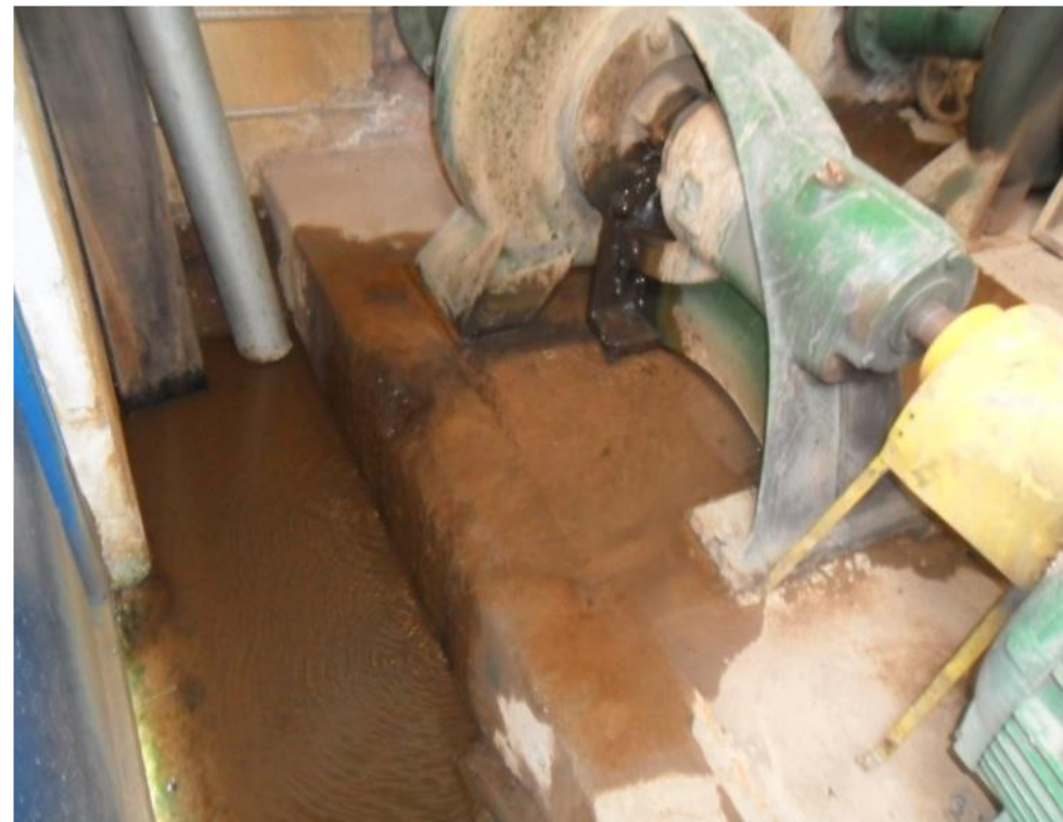
Vazamento excessivo da gaxeta da bomba na Captação Caxambu Itupeva – SP/2015
